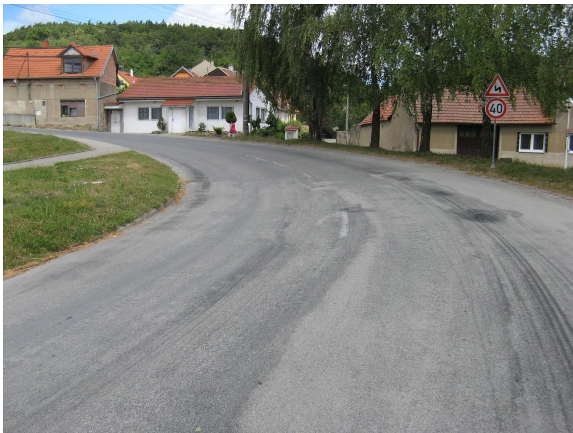
F05, sil. III/37930, km 0,060+, za křiž. se sil. III/37926 Plošné deformace v celé šířce vozovky.
