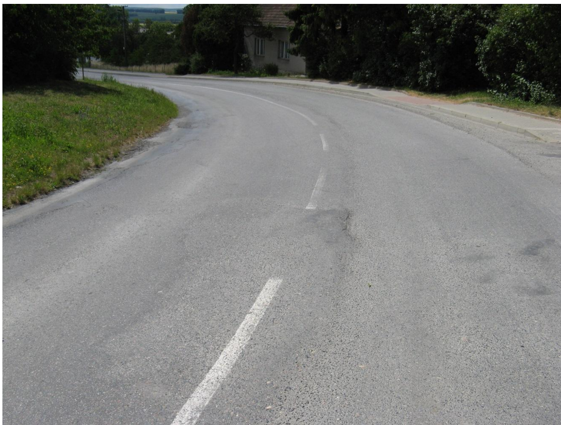
F19, sil. III/37930, km 0,350- Vyjeté koleje a nepravidelné hrboly.
