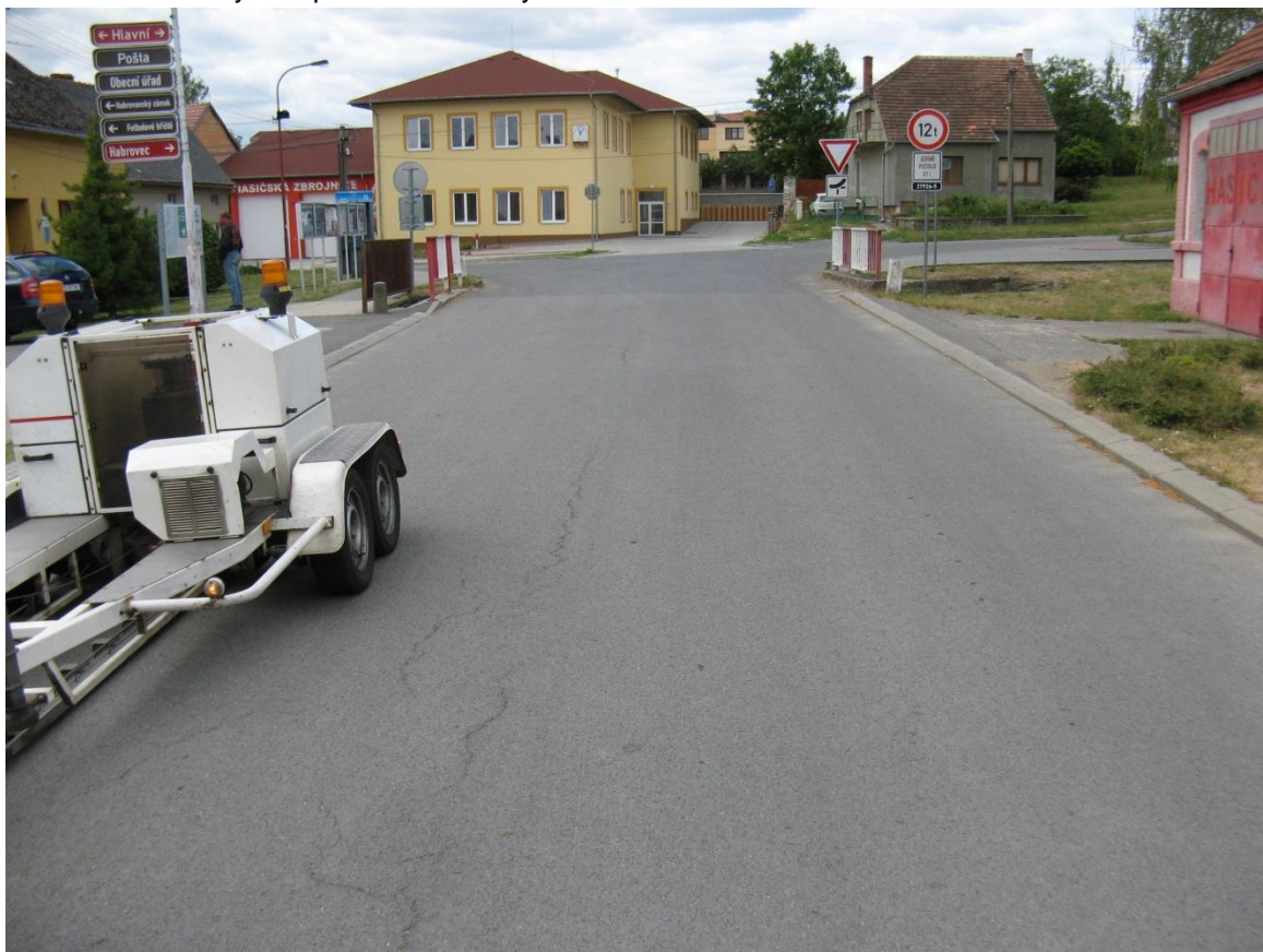
F27, sil. III/37926, km 0,050- Podélná rozvětvená trhlina.
