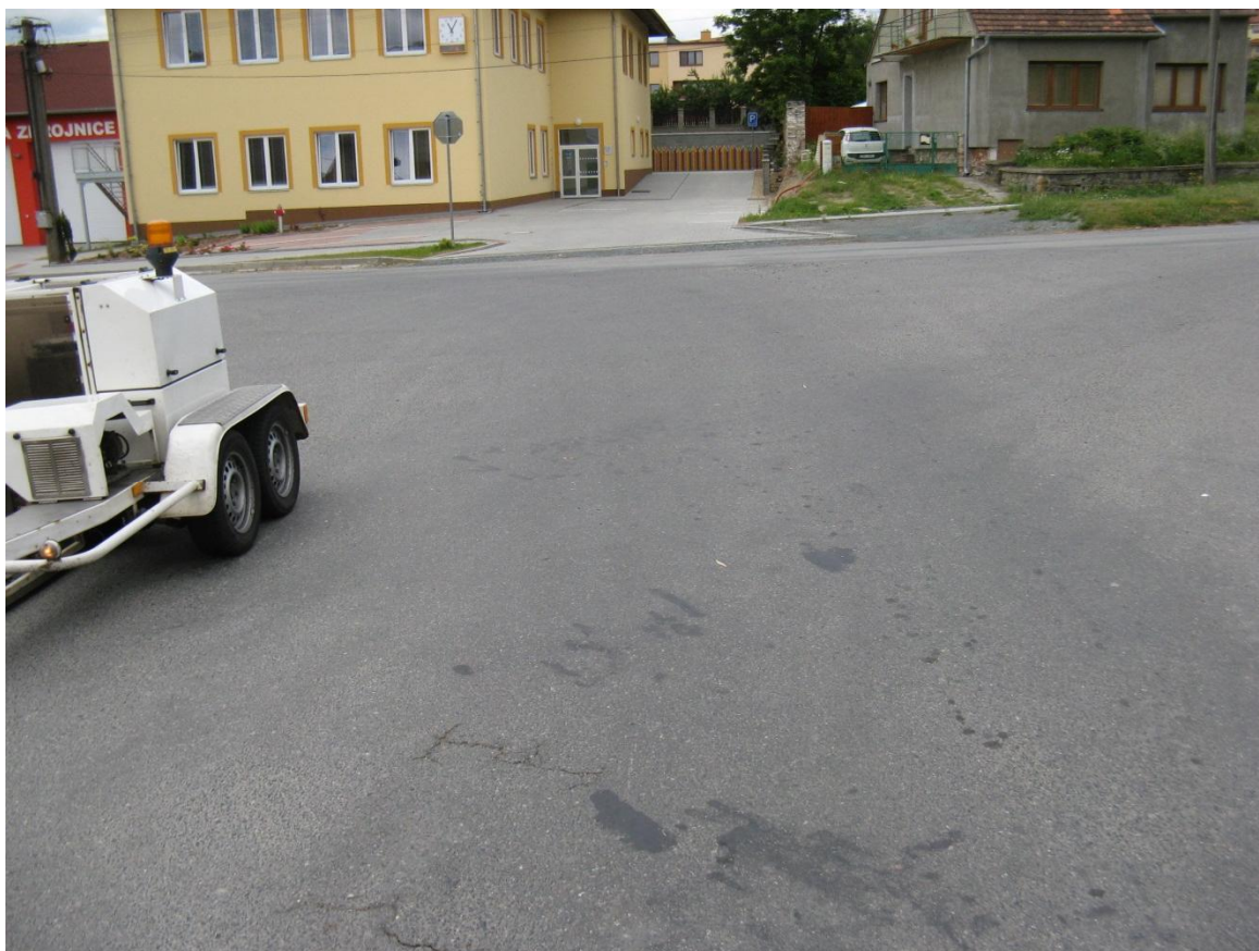
F25, sil. III/37926, km 0,020- Mozaikové trhliny a nepravidelné hrboly.
